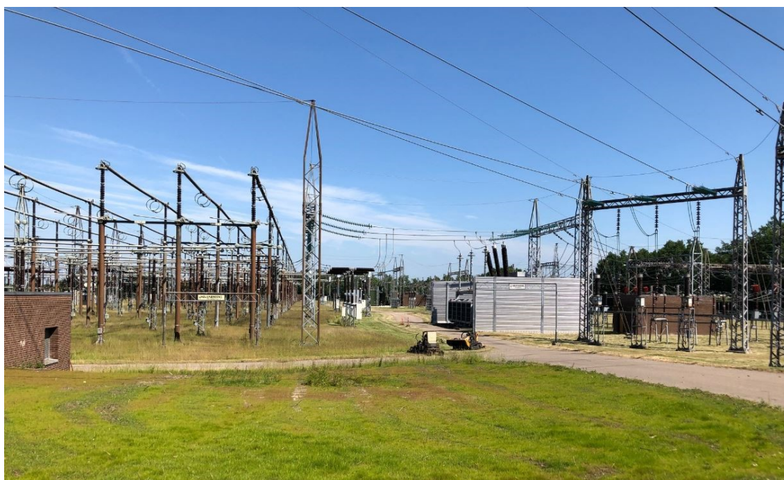
Figur 4.5: Støjafskærmning på den eksisterende Hovegård Højspændingsstation.
